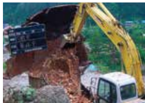
焼却施設解体
