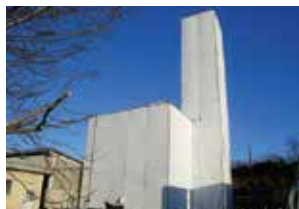
仮設足場設置状況
