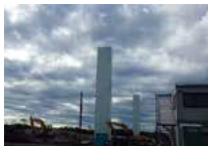
仮設足場設置状況
