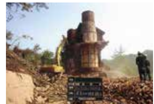
焼却施設解体
