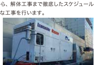
超高压水発生装置設置
