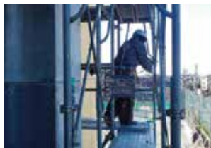
仮設足場組立中
