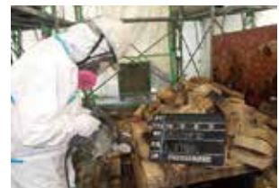
焼却施設解体
