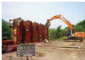
焼却施設解体
