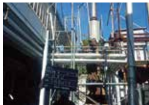
仮設足場組立中
